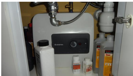
Figura 4.15 - Bollitore elettrico con accumulo
