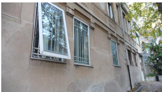
Figura 4.6 - Particolare della vetrata esposta a sud – Piano terra
