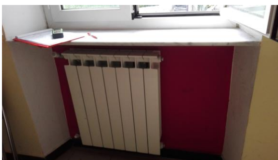
Figura 4.9 – Particolare – radiatore in alluminio
