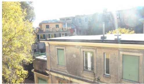
Figura 8.1 – Copertura dell'edificio non accessibile
